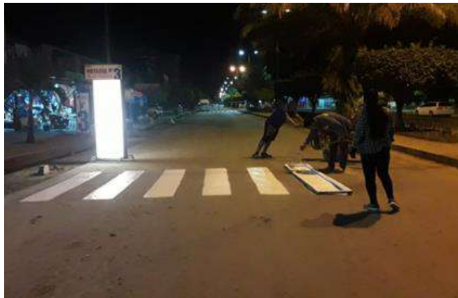
PINTADO DE SEÑALIZACIONES
